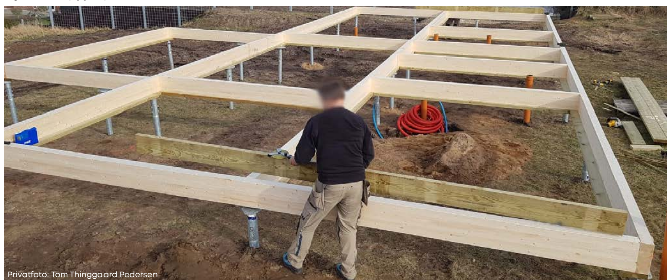
Figur 2: Træbyggeri på skruefundament, 2021
